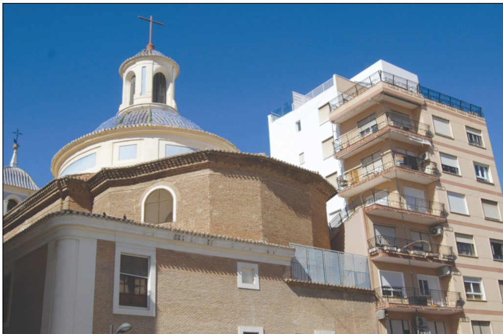
FIGURA N° 3. Presión urbanística sobre la iglesia de San Lorenzo (Murcia). Fuente: Palazón.
