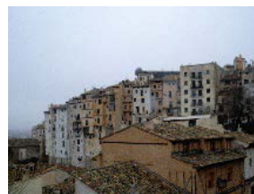
Parada 6 Arquitectura popular y materiales constructivos
