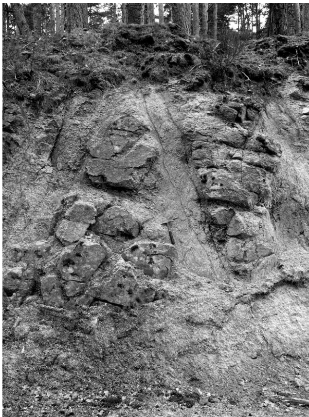
FIGURA nº 6. Alteración de los granitos a partir de las fracturas en el Puerto de Canencia. Elaboración: autor.
